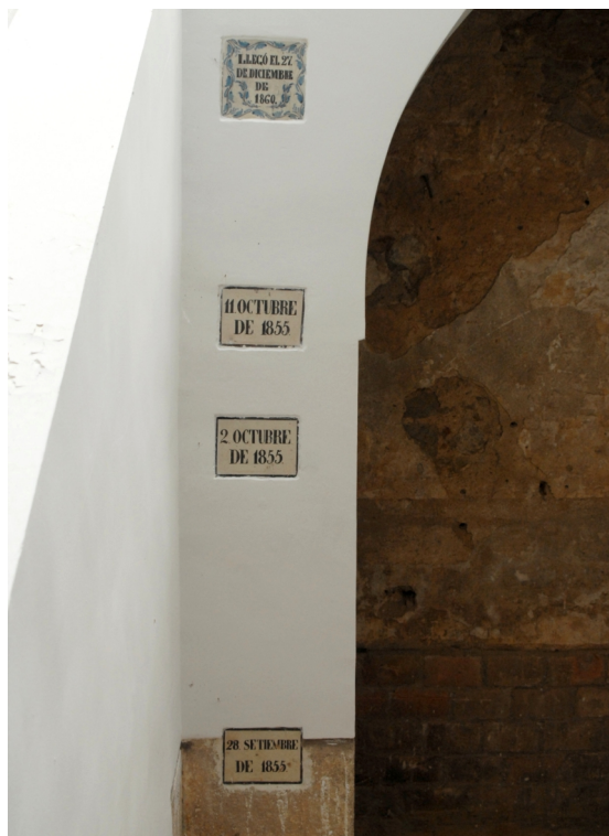
Figura 2. Conjunto de cuatro placas de azulejo marcando las alturas de la lámina de agua y las fechas en las que se produjeron diversas inundaciones en el edificio Sabatini de la Fábrica de Armas de Toledo, a lo largo de la segunda mitad del siglo XIX. A pesar de tratarse de la mayor concentración en España de placas de inundación de diversos eventos de crecida (más de 15), algunas de ellas fueron eliminadas y extraviadas durante el proceso de rehabilitación de los edificios para albergar el campus de la Universidad de Castilla-La Mancha. Ejemplo de elemento cultural de origen antrópico e interés geológico. Foto: Ignacio Gutiérrez Pérez.
